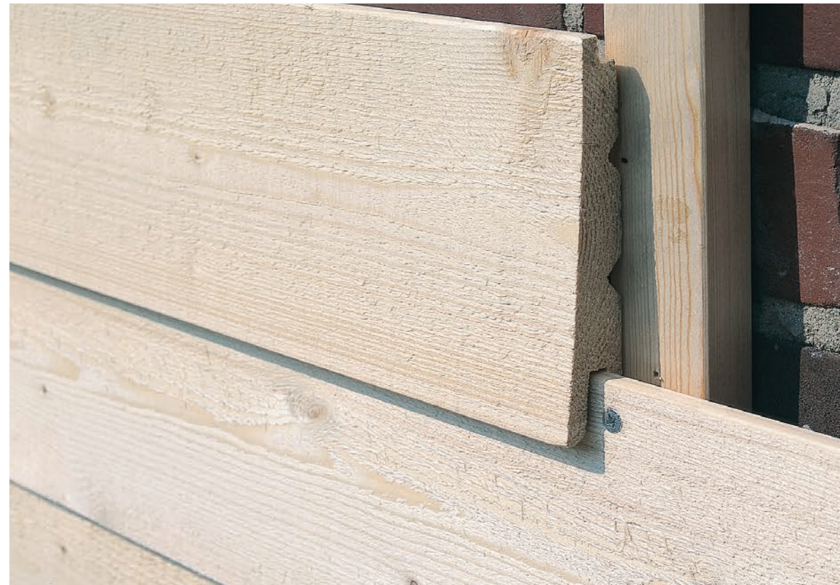
施工例：外壁にWRウォーターレペントを1回下塗り
