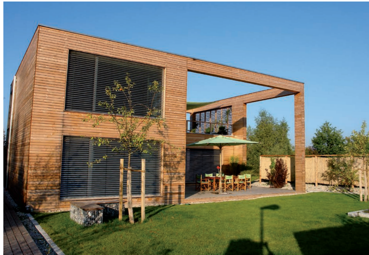
施工例：外壁に外装用クリアープラス2回塗り
