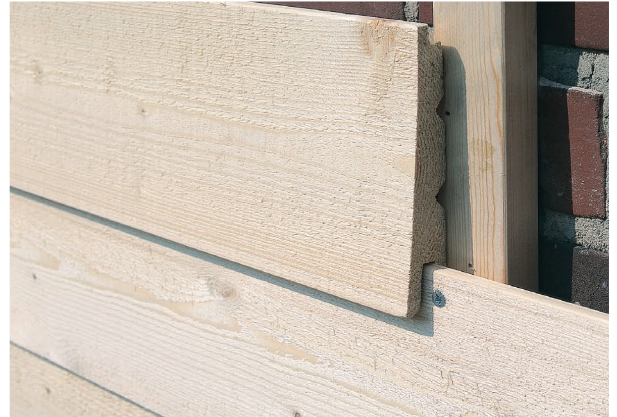
施工例：外壁にWRウォーターレペントを1回下塗り
