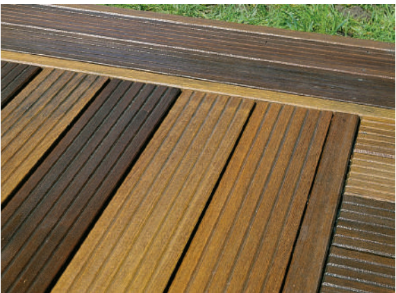
使用后、ウッドステインプロテクターを2回塗り
