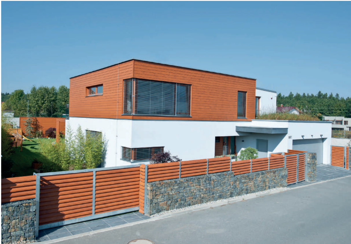
施工例：外壁に#728 レッドシーダー 2 回塗り
