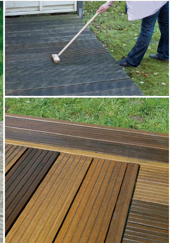
使用后、ウッドステインプロテクターを2回塗り
