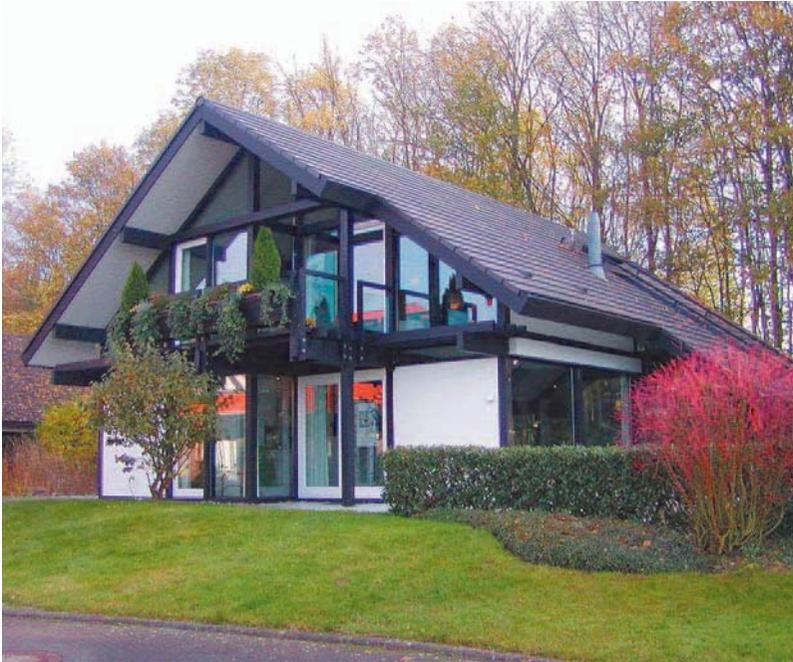
切妻の部分まで大きくガラス開口を設け外光を積極的に室内に取り込むデザインです。ドレーキップを多用し換気にも配慮しています。断熱性能の高い白いPVC樹脂サッシを採用し、省エネとともにメンテナンス性も向上しています。
