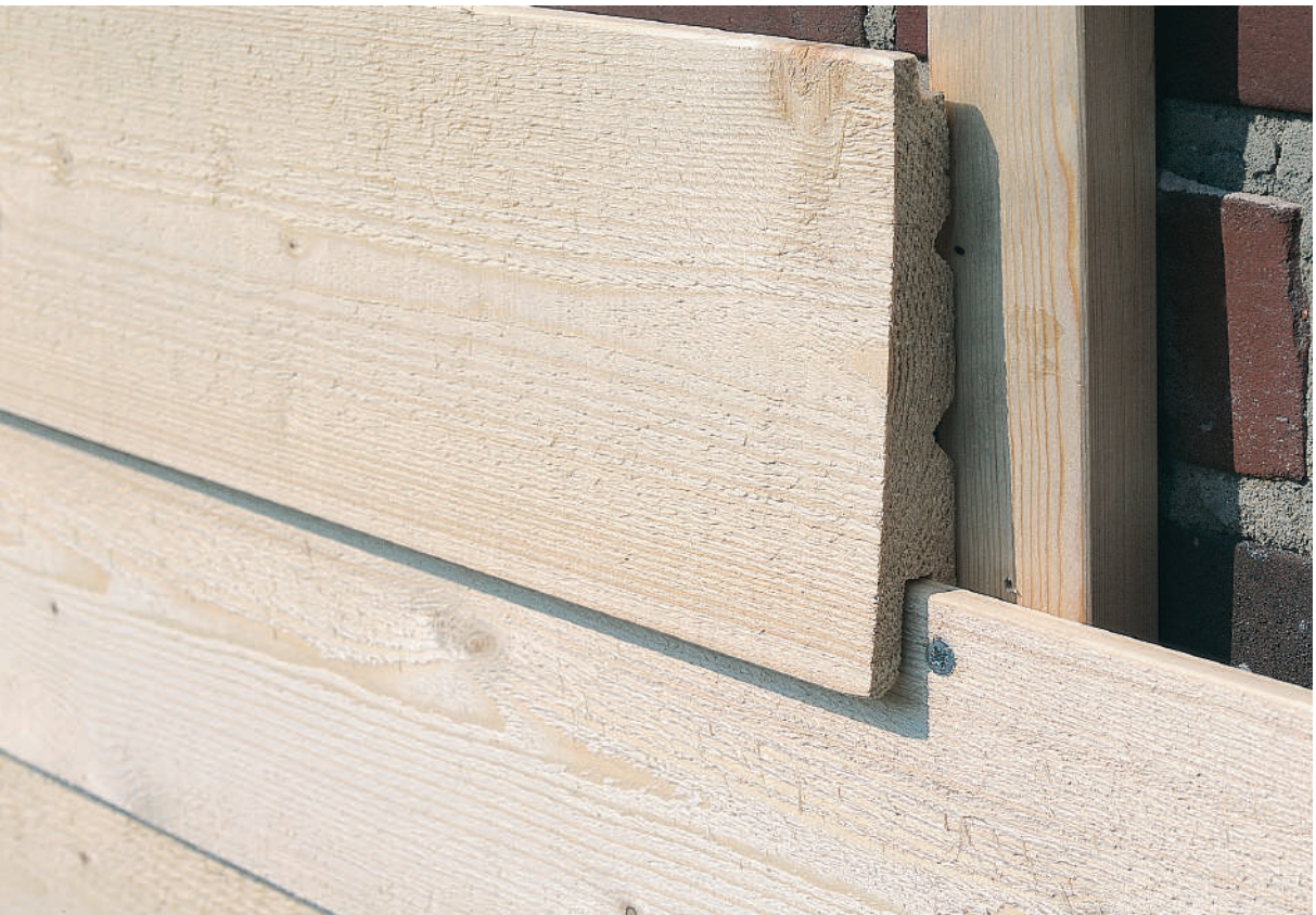
施工例：外壁に WR ウォーターレペレントを 1 回下塗り
