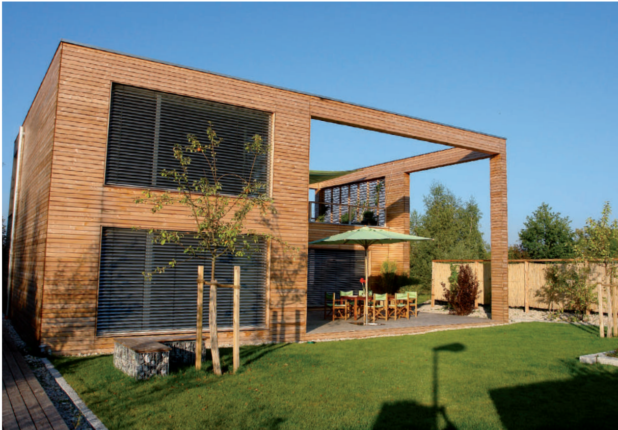
施工例：外壁に # 420 外装用クリアープラス 2 回塗り
