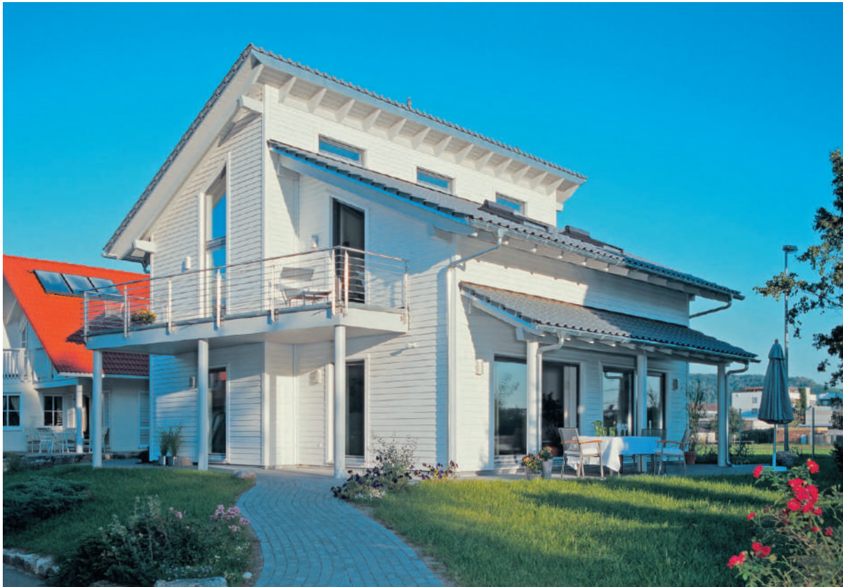
施工例：外壁に # 2101 ホワイト 2 回塗り
