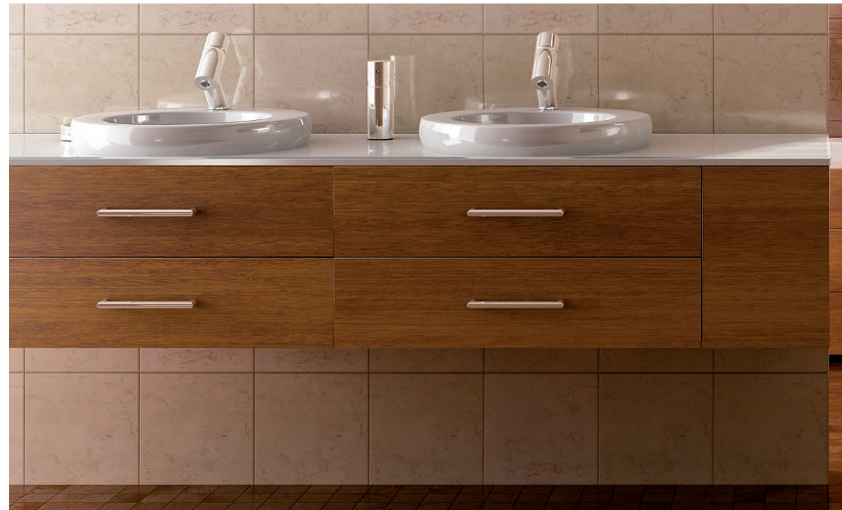
施工例：洗面木部に #4006 ウッドプロテクターを下塗り、#3101 ノーマルクリアー上塗り
